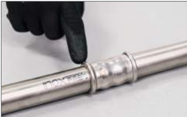
Controllo della pressatura / Checking the press connection
