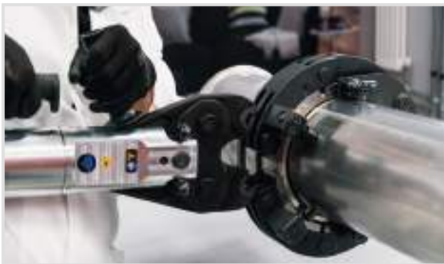
Assemblaggio pressatura n°1 / Press assembly phase 1
